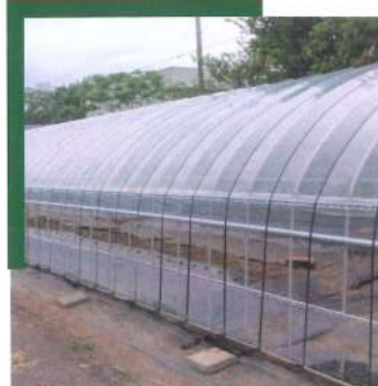
パイプハウス
